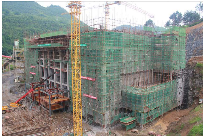
即将建成的贵州遵义垃圾焚烧处理项目
