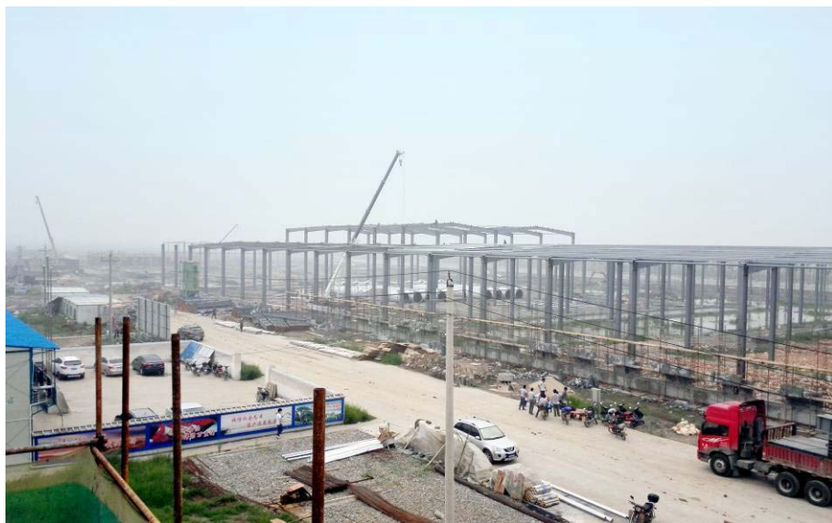
安徽海创新型建材公司工程建设全景
